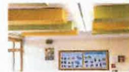
Hochleistungsabsorber-Elemente wurde an der Decke des Werkraums angebracht
