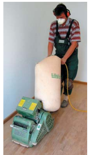
Lärm- und Atemschutz beim Bodenschleifen
