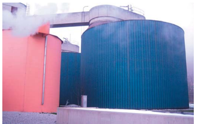
Faulturm einer Kläranlage
