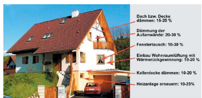
Heizkosteneinsparung durch thermische Sanierung
