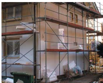
Vollwärmeschutz wird aufgebracht
