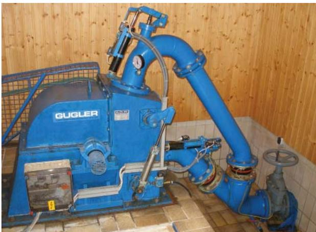
Kleinstwasserkraftwerk Trattenbach mit 31,5 kW
