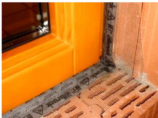
Auf der Innenseite ist dafür eine diffusionsdichte Abdichtung nötig, auf der Außenseite muss eine diffusionsoffene und schlagregendichte Abdichtung angebracht werden.
