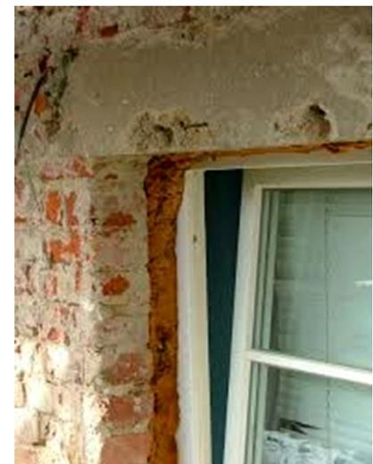
Ein Einbau nach Norm B 5320 ist nötig. Das bedeutet, dass bei den Anschlussfugen sowohl außen als auch innen Dichtungsbänder angebracht werden müssen.
