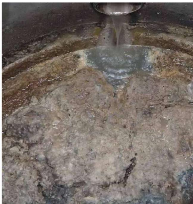
Abb. 5: Fettablagerungen im Kanalsystem; Abwasserverband Grazerfeld
