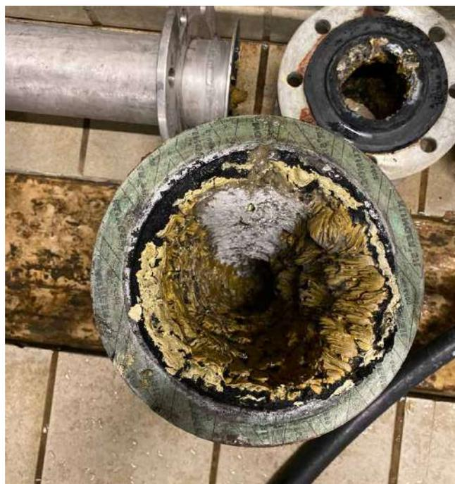
Abb. 6: erstarrtes Fett an Rohrleitungen; Abwasserverband Grazerfeld
