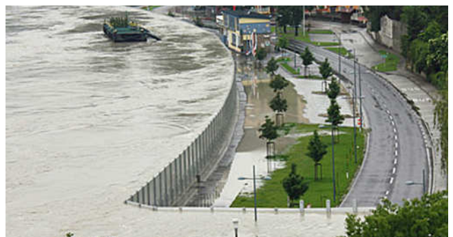
Abb. 9 bis 11: oben: Intakte Auen (im Bild Donau-Au) dämpfen Hochwasserwellen; Mitte: Rückhaltebecken am Marbach (Gemeinde Grafendorf/Stmk.). Quelle: Land Steiermark; unten: Hochwasserschutzbauten während des Donauhochwassers 2013. Quelle: Der Standard/Robert Zinterhof
