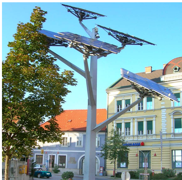
Abb. 4: Solarbaum am Gleisdorfer Hauptplatz
