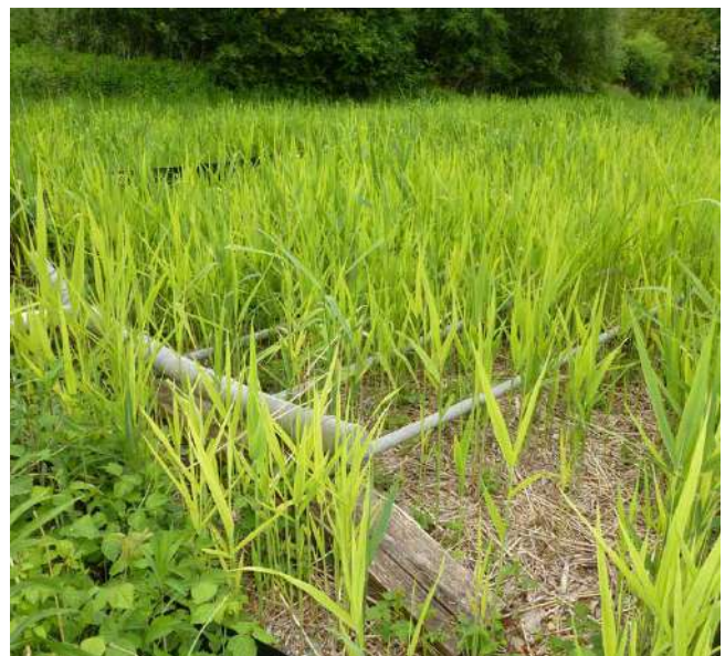
Abb. 32: Pflanzenkläranlage; E. Lenhard
