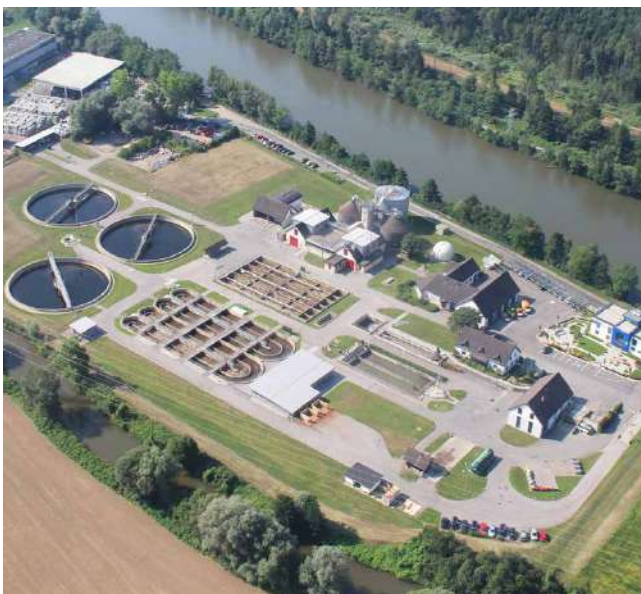
Abb. 31: Abwasserreinigungsanlage Grazerfeld; AWV Grazerfeld
