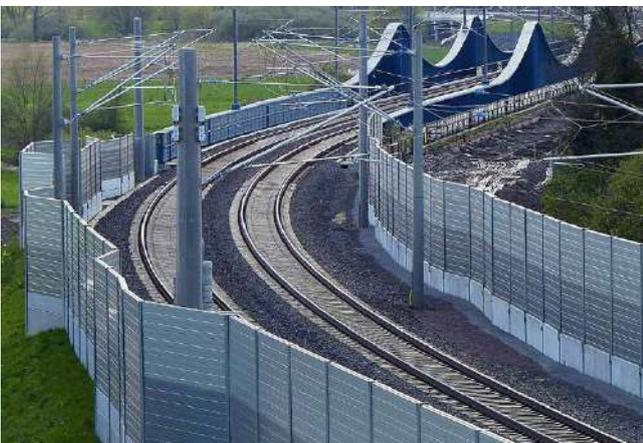
Abb. 51: Lärmschutzwände entlang von Bahngleisen; bernswaelzl/pixabay.com
